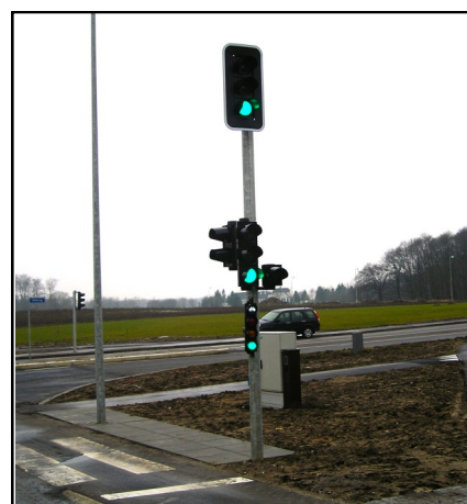
Eftergivelig konisk trafiksignalmast.
