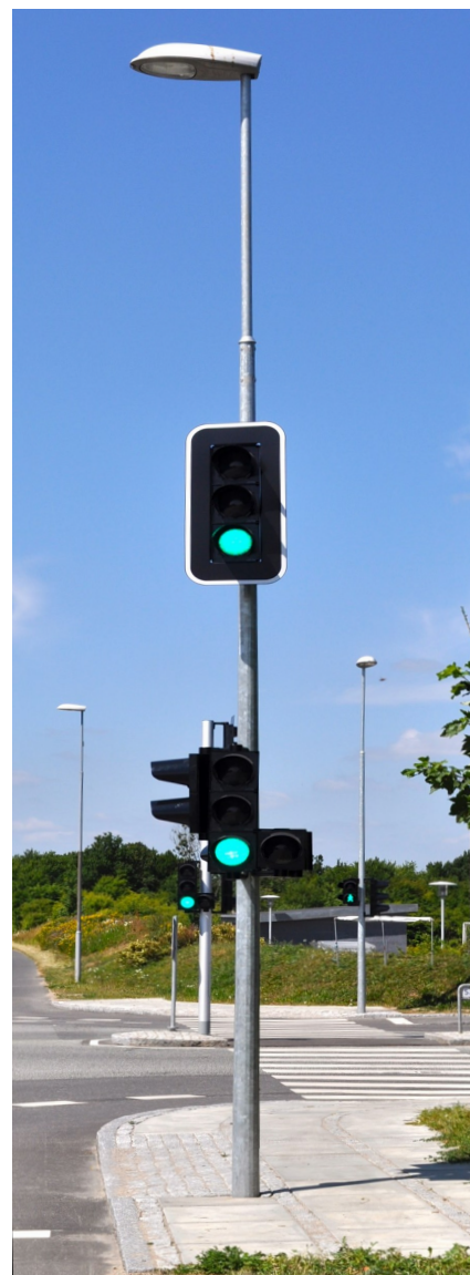
Eftergivelig konisk trafiksignalmast.
