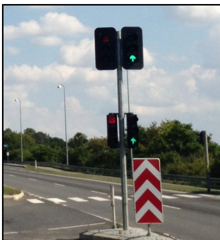
Eftergivelig oktogonal trafiksignalmast
